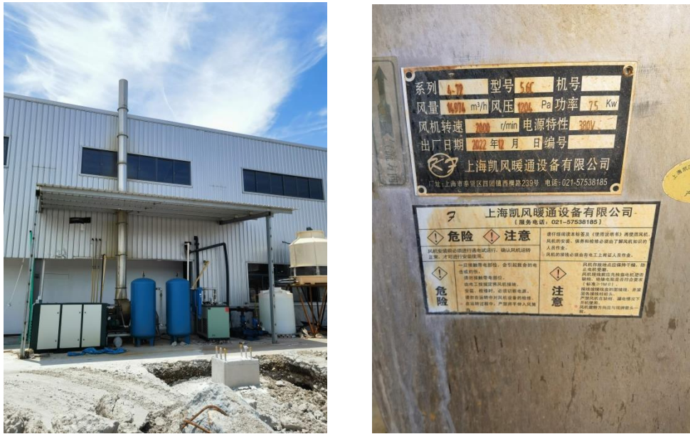
图 4-10 排气筒及风量参数
