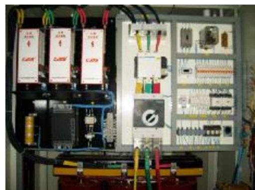
图 2-9 高频振荡器可控硅交流调压系统
